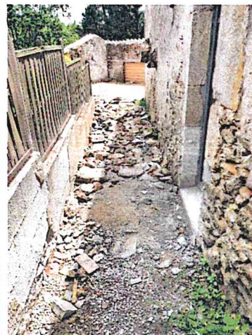
Photo 1 – en cours de remblaiement
