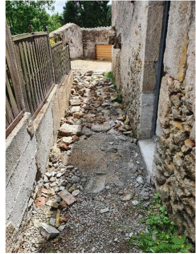
Photo 1 – en cours de remblaiement
