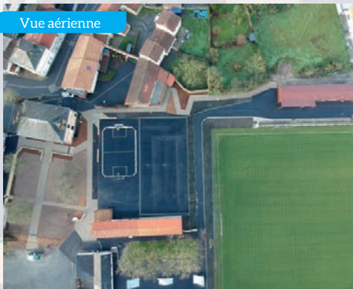
Vue aérienne de l'ensemble du nouvel espace
