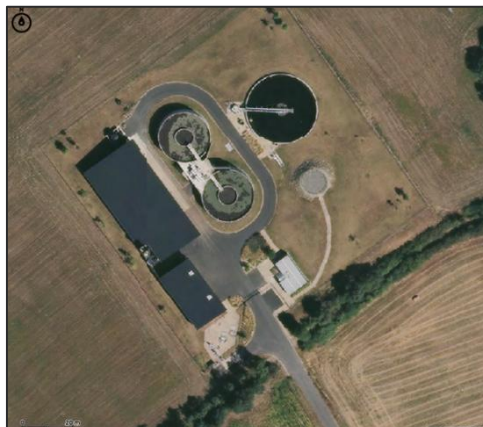
FIGURE 7 – VU AERIENNE DE LA STATION D'EPURATION DE MONTAIGU AGGLOMERATION
